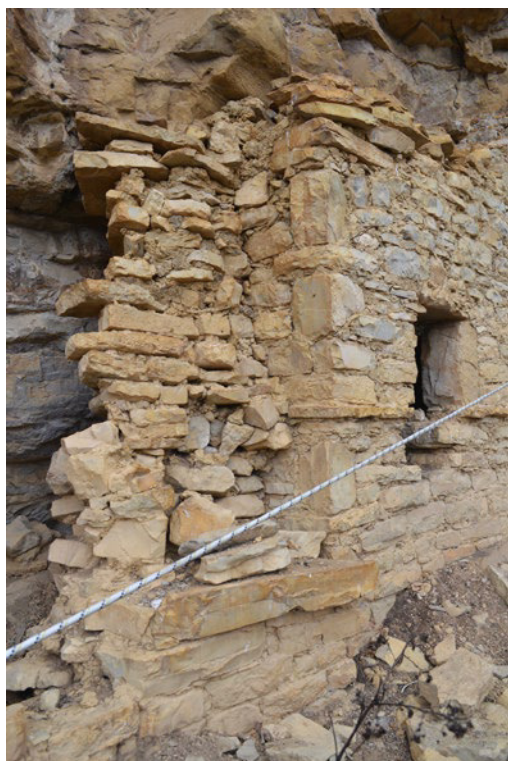
Figura 6. Foto del mausoleo Sup EF-14 (izquierda, con albañilería de pobre organización) y chullpa Sup EF-15 (derecha, con albañilería de mejor calidad) mostrando técnicas constructivas diferentes en tumbas adyacentes.
