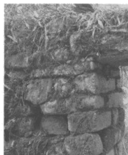
El tambo localizado en el camino inca se encuentra sobre el desfiladero.
